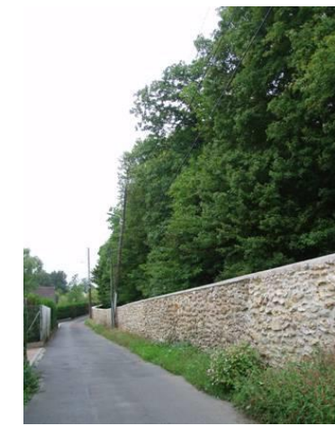
Figure 268 : Mur d'enceinte restauré
