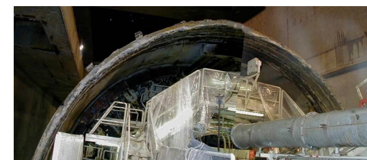
Figure 293 : Vue du tunnelier utilisé lors de la réalisation du tunnel A86 Ouest
