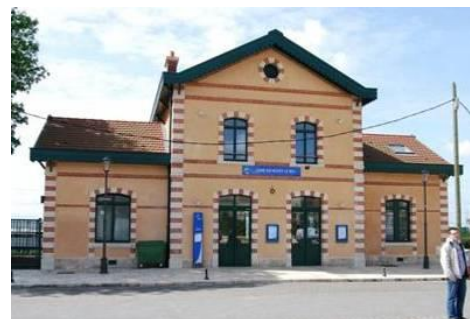
Figure 243 : Gare de Noisy-le-Roi
