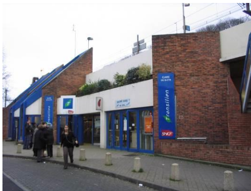
Figure 242 : Gare de Saint-Cyr
