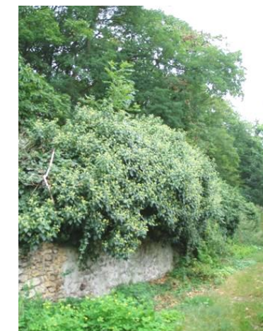
Figure 270 : Mur d'enceinte restauré
